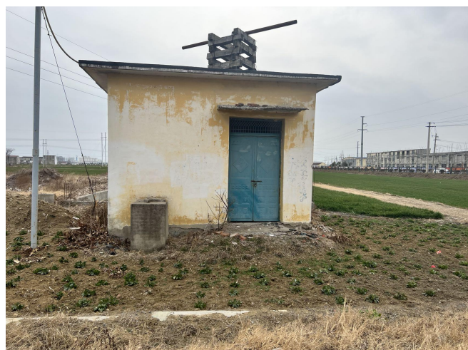
进场道路南侧水源井
